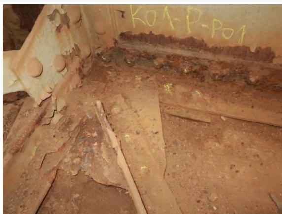
Foto č. 6 Konstrukce K 01 – podélné ztužení, styčnickový plech, 8. příčník vpravo, oslabení
