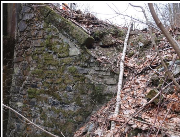
Foto č. 20 Opěra O 01 - křídlo vlevo - rozvolněný konec křídla a římsy
