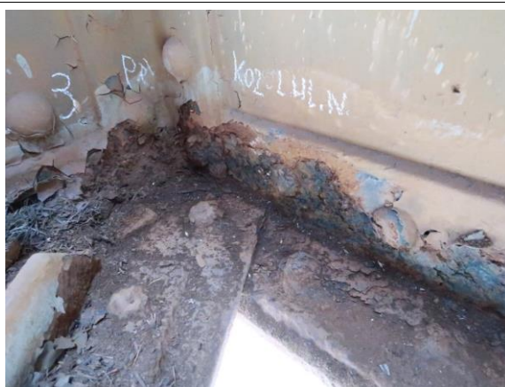
Foto č. 8 Konstrukce K 02 – levý hlavní nosník 3. příčník oslabení
