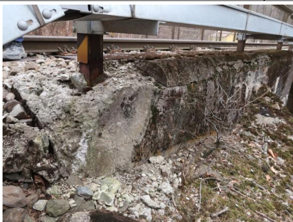
Foto č. 19 Opěra O 01 - římsa vpravo začátek - degradace
