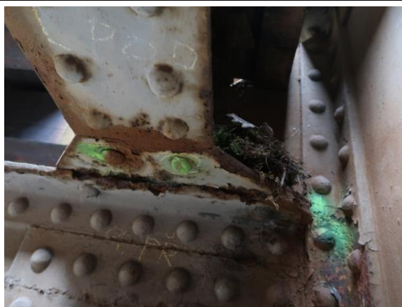
Foto č. 14 Konstrukce K 02 – 9. příčnicí, napojení, na levý podélník, volné nýty
