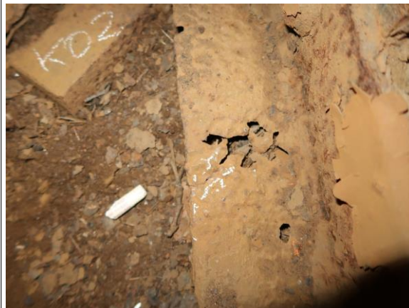
Foto č. 16 Konstrukce K 02 – 9. příčník vlevo, oslabení trhлина
