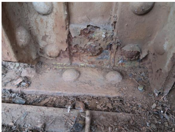
Foto č. 3 Konstrukce K 01 – Pravý hlavní nosník, trhlina nad ložiskem P 01 vpravo
