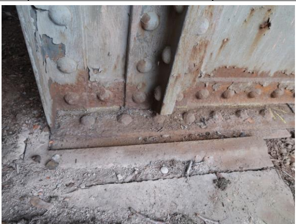
Foto č. 9 Konstrukce K 02 – pravý hlavní nosník, začátek vně trhlina
