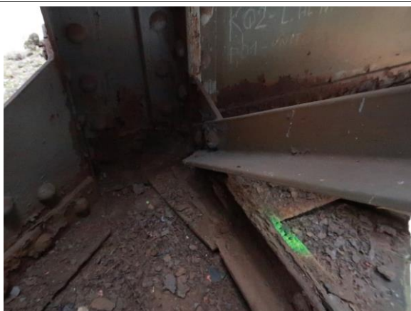
Foto č. 7 Konstrukce K 02 – levý hlavní nosník, začátek oslabení
