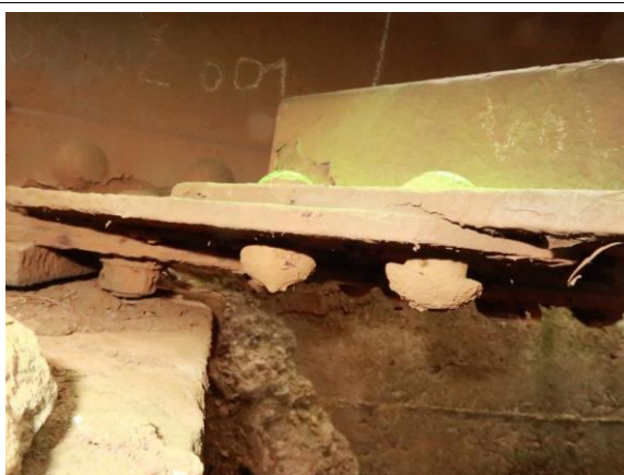
Foto č. 5 Konstrukce K 01 – podélné ztužení vlevo v prvním poli, uvolněné nýty
