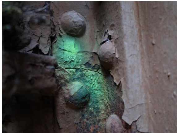
Foto č. 4 Konstrukce K 01 – levý hlavní nosník, připojení 9. příčnicku, trhlina v krčním úhelníku
