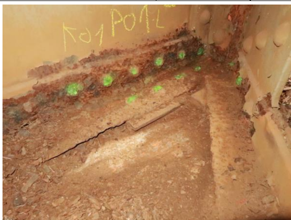
Foto č. 1 Konstrukce K 01 – levý hlavní nosník, konec, oslabení
