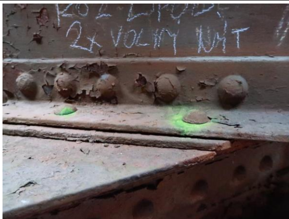
Foto č. 13 Konstrukce K 02 – 2. příčnicí, napojení na levý podélník, volné nýty
