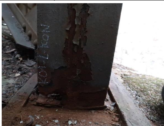
Foto č. 2 Konstrukce K 01 – levý hlavní nosník, konec, oslabení
