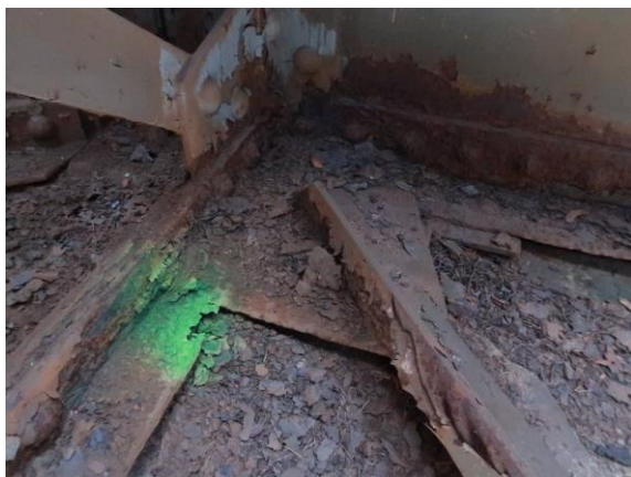
Foto č. 15 Konstrukce K 02 – 2. příčník vlevo, oslabení
