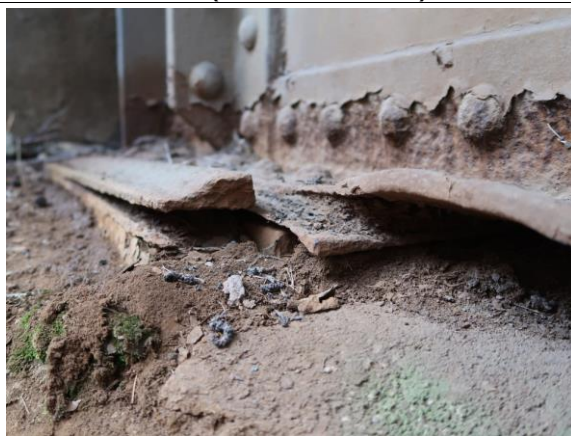
Foto č. 18 Konstrukce K 02 – ložisko nad O 02 vlevo – uvolněná zarážka
