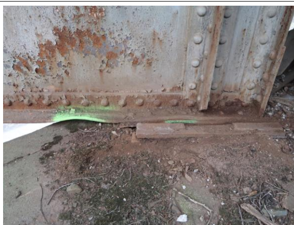
Foto č. 12 Konstrukce K 02 – pravý hlavní nosník konec deformace, trhлина
